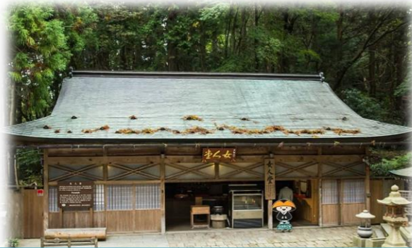
不動坂口女人堂。参詣を禁止されていた女性のための さんくじじょ 参籠所。かつては高野山への登り口、 こうやななくち 高野七口にそれぞれ存在したが、現在は不動坂口の女人堂のみ残る。
