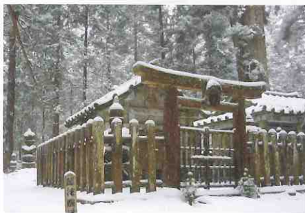
修復後の様子
