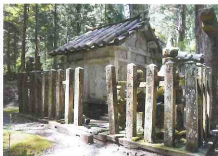
修復前の様子
