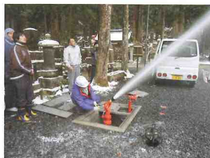
茶処前 地下式放水銃 水圧をかける事により自動で地上に上がってくる
