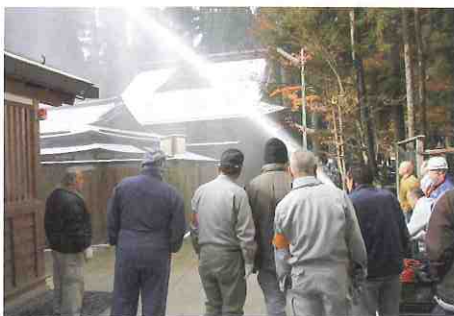
御供所横 放水銃
