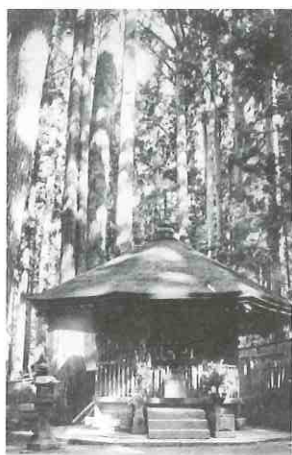
奥の院納骨堂 大正時代 改築以前の状況 篠原行雄氏所蔵絵ハガキより複写
