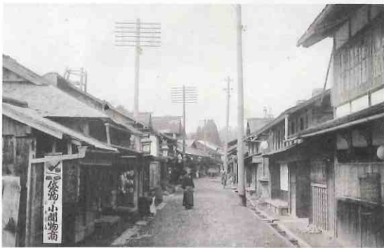
大正～昭和初期の高野山内とする写真（絵ハガキ） 山内の道路は大正時代から昭和にかけて順次拡幅されていきます。写真は拡幅以前の状況を示しているものと思われませんが、場所の特定はできていません。
