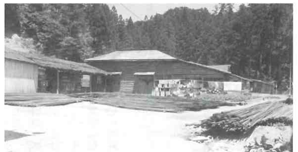
⑩高野索道 大門 昭和35年より始められた霊宝館大宝蔵の建設により多くの資材が索道で運び上げられました。写真は大宝蔵建設資材の一部です。
