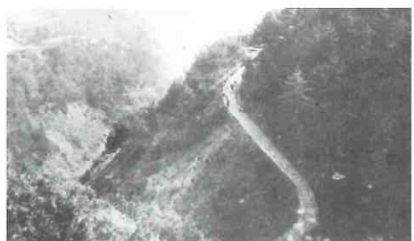
⑤高野索道と木馬道 山の中腹を斜めに下る木材運搬用の木馬道とその向こうには索道が通っています。写真の場所は推出から山谷へ至る長坂街道付近かと思われる。
