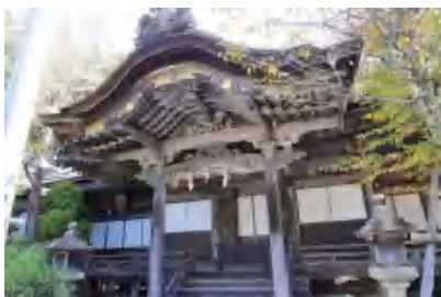
本堂の外観 正面中央に唐破風造りの向拝が付き、軒下部分は豪華な彫刻で飾られている。本堂の左右には、一間奥に後退して「脇陣」といえる建物が接している。
