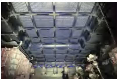
本堂の天井 「二重折り上げ小組格天井」という形式で、漆塗り、金色の金具で装飾されている。これだけ格式高く豪華な天井は高野山内には他に無いだろう。東照宮拝殿の遺構であることを確信させる意匠である。
