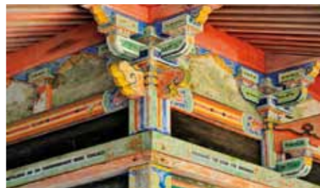
霊屋の木鼻詳細 よく見ると、右と左で木鼻の輪郭が全く異なっている。2棟あった霊屋の部材を使って一つの建物に改造した事を物語っているようである。様式的には左の方が古式である。
