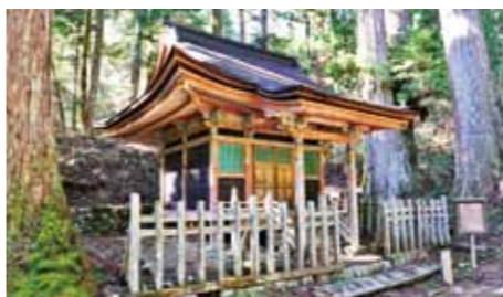
上杉謙信霊屋の全景 正面3間、側面2間、入母屋造り、向拝付き、檜皮葺の霊屋である。右手には空地があつて、かつてはそこに、養子「上杉景勝」の霊屋があつたようである。
