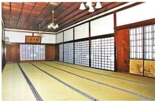
「大広間」の正面側を室内から見返す 棧唐戸の内側には腰高障子が、部戸と舞良戸および中門境の杉戸の内側には、上から下まで全面に紙を貼る明障子が建て込まれている。
