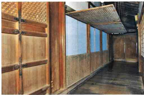
「大広間」の正面側を広縁から見る 左が棧唐戸で、右は部戸。部戸の内側には明障子が建て込まれている。広縁の突き当たりには杉戸がある。
