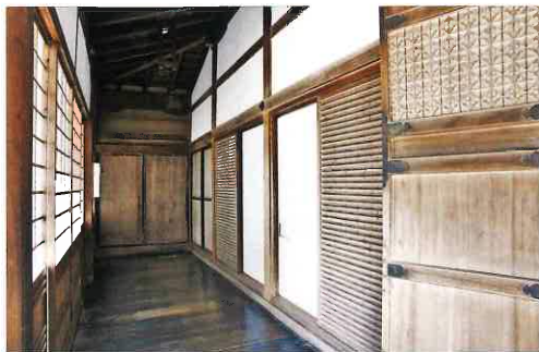
「角の間」の正面側を広縁から見る 棧唐戸の左が舞良戸で、開けた状態。内側に片引きの障子が入っている。その奥には「帯戸(おびと)」が、広縁の突き当たりには杉戸がある。
