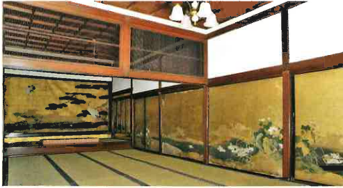
「次の間」から「上段の間」「上段」を見る 上段の間は賓客をもてなす場で、豪華な書院造りとなっている。次の間の天井は「竿縁天井」、上段の間は「格天井」。写真では見えないが「上段」は「折り上げ小組格天井」である。
