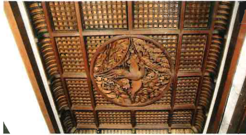
「上々段」の天井 「次の間」から「上段の間」「上段」「上々段」へと、天井はその意匠を異にする。「上々段」は最も豪華で、中央に鳳凰の彫刻を嵌め込んだ「折り上げ吹寄せ小組格天井」となっている。
