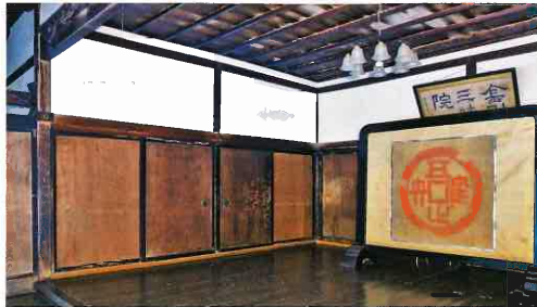
「中門」の全景 玄関を入ると、「中門」と呼ばれる広い板敷きの間がある。左手の杉戸の奥が客殿で、写真には写っていないが右が台所となる。写真の左上に正面の虹梁が少し写っている。
