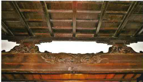
「中門」正面の虹梁に彫られた鯉の彫刻 虹梁の中央に魚の彫刻が彫られている。ここは「登龍門」で、この先に龍になるための、厳しい修行が待ち構えていることを暗示しているようだ。
