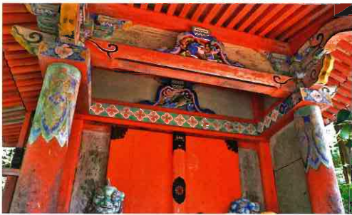
「身舎」正面の詳細 「身舎」の正面には虹梁が架けられその下は開放となっていて、社殿の扉は奥まった位置に設けられている。扉上の墓股には魚の彫刻が彫られ、「登竜門」を暗示しているようだ。
