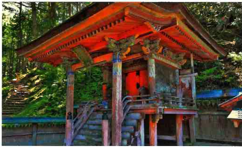
社殿正側面の全景 形式は「一間社春日造り」。正面の柱間は1.2mと小規模だが、様式、技法ともに正規の造りである。土台建て、持送り形式の縁は奈良春日大社の技法を取り入れたのだろうか。
