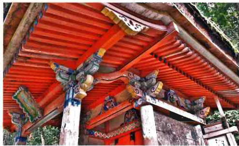
組物と軒の見上げ 「身舎」と「向拜」を湾曲した「海老虹梁」で繋ぎ、その曲線をうまく利用して、春日造り独特の複雑な軒廻りを巧みに納めている。木鼻は少し大振り、丁寧な造りとなっている見応えがある。
