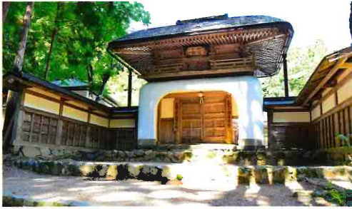
山門の全景 楼門という形式だが、下層は漆喰壁で覆われている。俗に「竜宮門」といわれるが、屋根の形が特異で、修行僧の「網代笠」のようだ。
