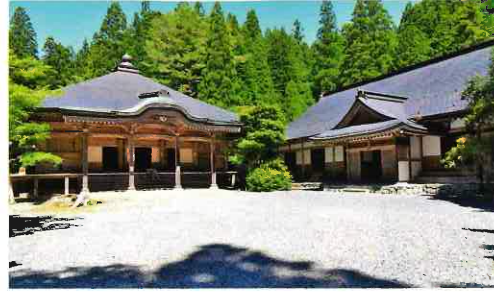
境内の全景 左が本堂、右が客殿台所。本堂は規模が大きく、正面には唐破風の付いた間口三間の向拝が付く。高野山内の寺院の中でも最大規模の本堂である。
