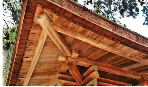
軒廻りの詳細 軒は厚い板を並べて造られている。床、壁、軒、すべてが木材で囲われた大きな木箱のような倉である。肘木（ひじき）と斗（ます）で桁を支える構法は他の校倉では見られず、これも特徴的である。
