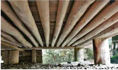
床下の様子 びっしりと並んだ丸太は「根太」で、その上に床板が張られている。こんなにたくさんの根太を架けるのは何故だろう。賊が床を破って侵入することを防ぐ工夫なのだろうか。
