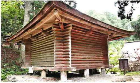
背側面の全景 断面五角型の「校木」が井桁組に積み上げられている。土台は太くて丸い束で支えられ、風通しの良い高床となっている。
