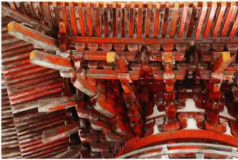
上層の詳細 上層は円形で、その上に四角の屋根を架けるのは至難の業だ。軒を支える組物は巧妙に造られている。
