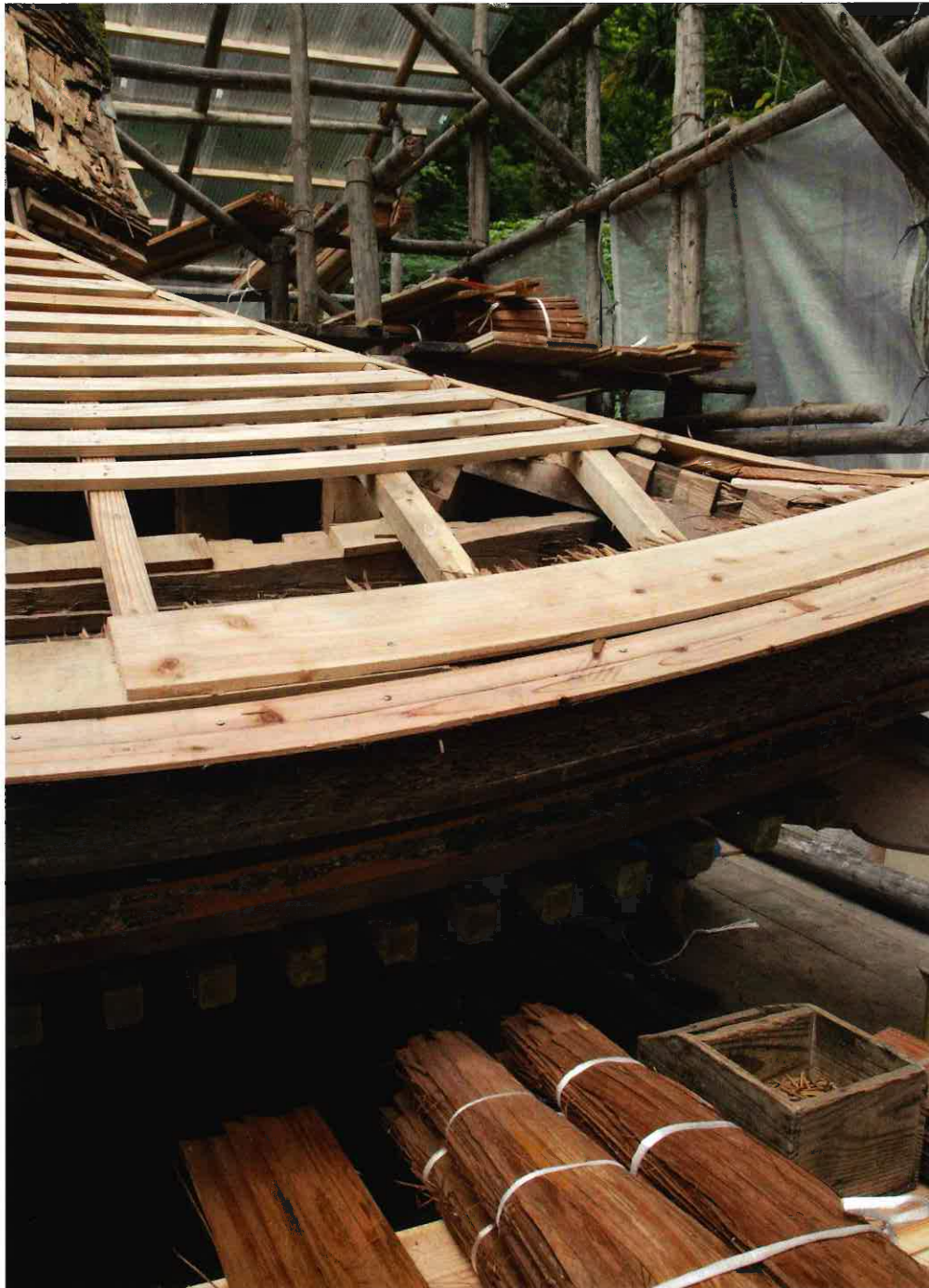
重文上杉謙信霊屋 屋根 一定の幅に切りそろえたヒノキの皮を、竹の釘で打ち付けて重ねていく伝統的な檜皮葺の技法です。
