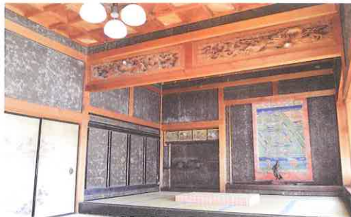
上段の間 灰色に見える壁面は「金唐革紙」という特殊な和紙が貼られている。欄間には院号の由来となった宝珠を戴いた勇壮な龍が彫刻されている。
