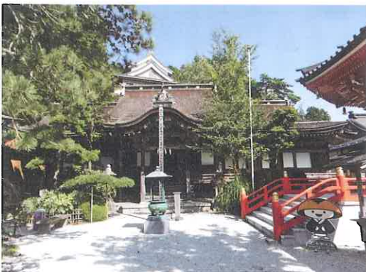
図8 普賢院本堂 外観 (興山寺東照宮拜殿)
