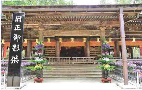
御影堂正面向拝の詳細 虹梁、木鼻、墓股には彫刻が施され、垂木の先端などに沢山の飾り金具が取り付けられている。伽藍で最も装飾された建物である。
