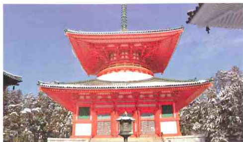
昭和12年に再建された現在の大塔 大規模な建築で、相輪の頂部まで「十六丈」(48.5m)ある。1200年前に創建された大塔の規模が忠実に伝えられていると考えられる。
