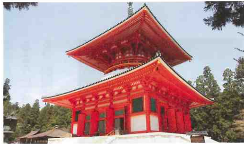
昭和12年に再建された現在の大塔 大規模な建築で、相輪の頂部まで「十六丈」(48.5m)ある。1200年前に創建された大塔の規模が忠実に伝えられていると考えられている。
