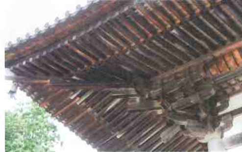
金堂の隅の見上げ 軒廻りや組物、そして柱などは木造で、平安時代初めの様式で造られているが、その内部には鉄筋コンクリート造の構造体が隠されている。
