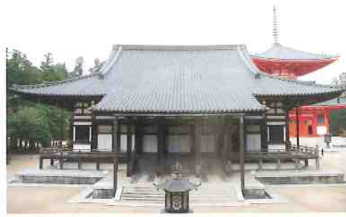
昭和9年再建の金堂 鎌倉時代の絵図では、金堂の屋根は檜皮葺のようだが、再建の金堂は銅瓦葺きで、防火を意識したようである。
