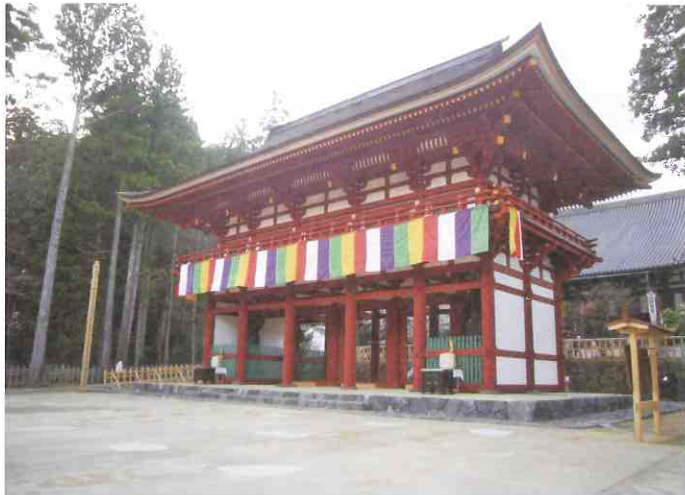
写真1 再建された8期中門 (写真手前の白い標示は7期中門礎石跡)
