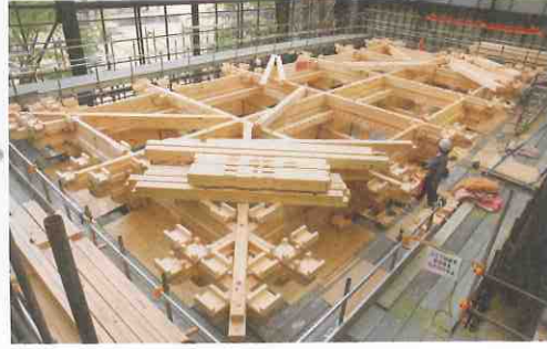
中門の組み立て作業 高野山で育った「檜」は、伐採、製材、墨付け、加工、組立と沢山の人の手を経て、中門という新たな建物の一つ一つの部材に生まれ変わった。
