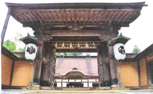
山門の全景 正面の柱間の寸法は約6m。全国的にも屈指の大規模な「四脚門」で、本山の正門にふさわしい。
