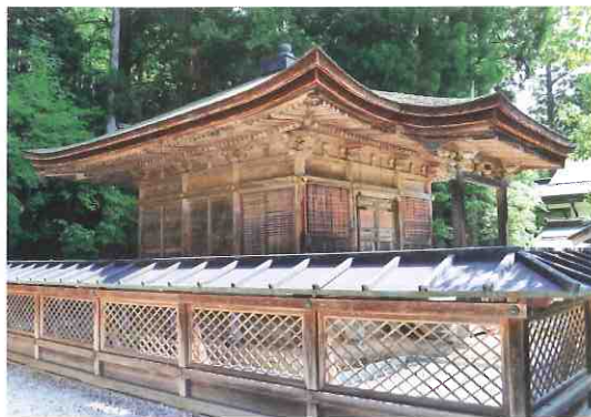
「真然堂」全景 寛永17年(1640)に建立された、桁行き3間、梁間3間、向拝1間、宝形造、檜皮葺の建物で、透塀に囲まれ静かにたたずんでいる。
