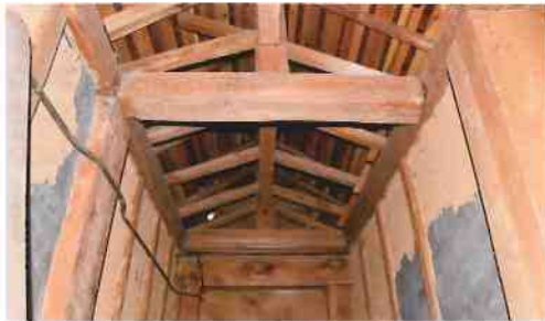
「かご堀」の内部 幅が1.7mある堀の内部は空っぽで、まさに「籠（かご）」のようである。中は十分立って歩ける広さで、物入れに利用されている。
