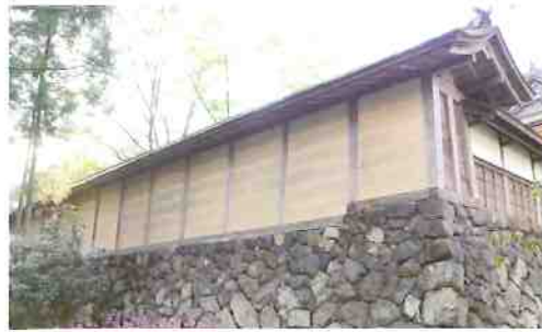
正面東側の「かご堀」 石垣の上に建つ堀は堂々として大寺の風格と威厳に満ちている。壁面には5本の白線が入る。「筋堀」という格式を表す形式である。
