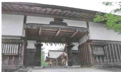
東面の通用門 通用門は「会下(えか)門」と呼ばれる長屋門です。奥に玄関の屋根が見えます。
