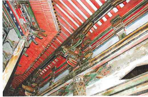
経蔵の内部 全面に彩色が施されている。左に輪蔵の軒先部分が見える。
