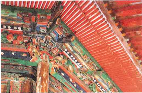
輪蔵の詳細 柱の直径は10cm。模型のようだが精巧に造られ、美しい文様彩色で彩られている。
