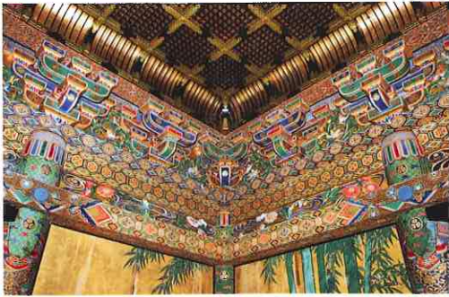
秀忠霊屋の内部 柱や長押、組物は鮮やかな彩色に彩られている。天井は黒漆に金箔貼りで、金色の飾り金具を打つ。
