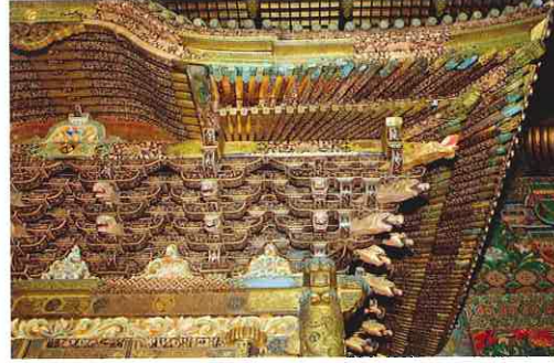
厨子の詳細 柱の直径は7.5cm。写真に写っている部分の幅は約1.1m。総ての部材に漆、蒔絵、飾り金具が施されている。
