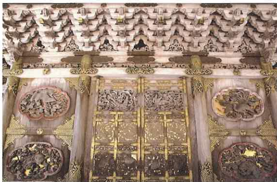
側面の全景 彫刻の嵌め込まれた扉や壁、上方の組物、辻々に所狭しと散りばめられた飾り金具など、装飾性に満ちている。
