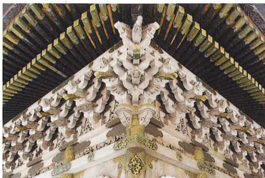
軒と組物の見上げ 軒は扇垂木。組物は「三手先」組物を詰め込むように並べ、とても賑やかである。
