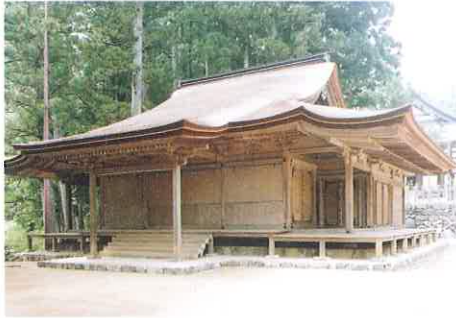
正面の全景 軒と屋根の納まりを見ると、向かって右側に庇を差し掛けて出来上がった姿であることが推察できる。
