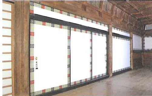
不動堂内部の襖 襖は柱間に3枚建てとなっている。敷居と鴨居は漆塗り。鴨居の上には「小障子」が建て込まれている。「鳥居障子」という形式の構えである。襖と小障子には絹の縁まわしを付け、襖の引き手は紐である。
