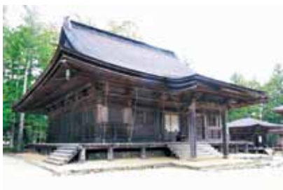
大会堂の全景 正面五間、側面五間で、正面中央に向拝が付いている。大建築だが、素木だからなのか、伽藍の中では余り目立たない。
