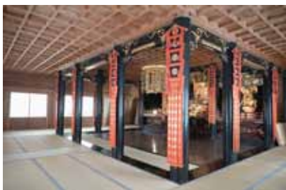
内部の詳細 内外陣境の柱と梁、須弥壇は漆塗りとなっているが、その他は節一つ無い上質の木材の清らかさが際立っている。一切の間仕切りの無い室内は「法会」の空間だったことを伝えているようである。
