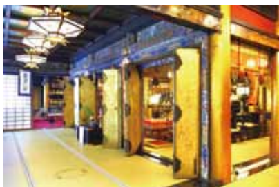
本堂の内部 写真右手の三間四方が「内陣」で、正面側には板唐戸が建て込まれ、写真左手が参詣者の着座する「外陣」となっている。内外陣を板唐戸で仕切るのは異例である。
