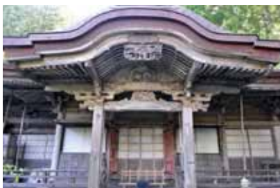
本堂の正面全景 本堂はほぼ七間四方で、中央に唐破風造りの一間の向拝が付いている。向拝廻りは建築彫刻で飾られている。
