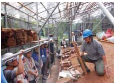
国宝 不動産屋根葺替工事現場見学会の開催風景 (9月21日)
