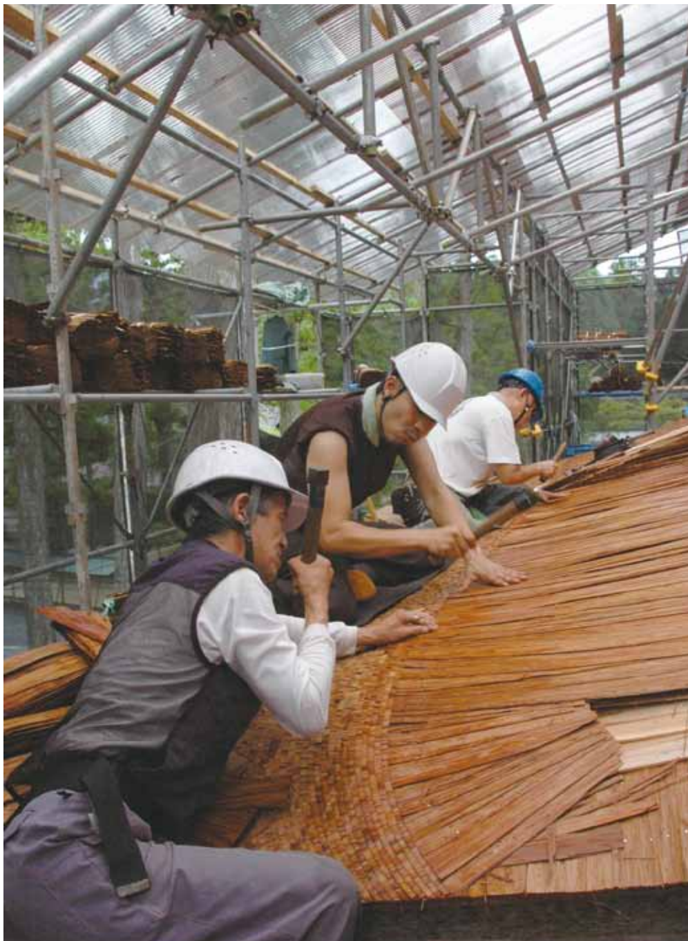
「国宝 不動堂」の檜皮葺屋根の葺き替え作業風景。檜皮材は、檜の幹の表皮を薄く剥ぎ取り、形を整えられた後、防腐のために燻した竹釘や鉄釘を留め具とし、屋根木槓へ屋根の野地板にテンボよく打ち付けられています。
